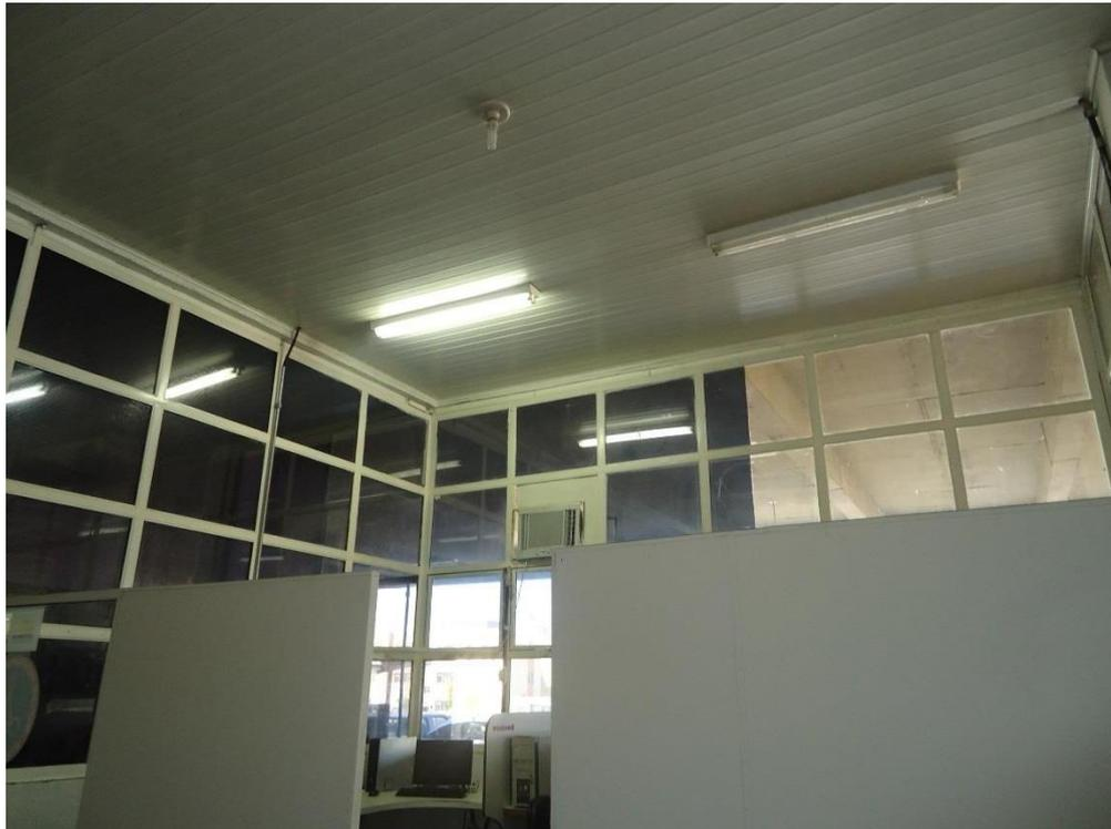
Reformas Previstas: Retirada de painéis de vidro, troca de piso suspenso, fechamento com alvenaria.
